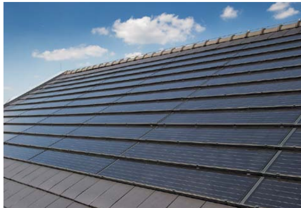
Zonnepanelen integreren in het dakvlak.
