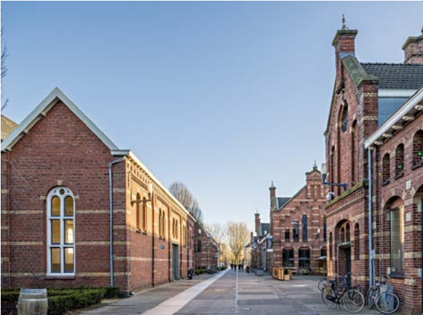
Shared space binnenstraat referentie: Westergasfabriek Amsterdam
