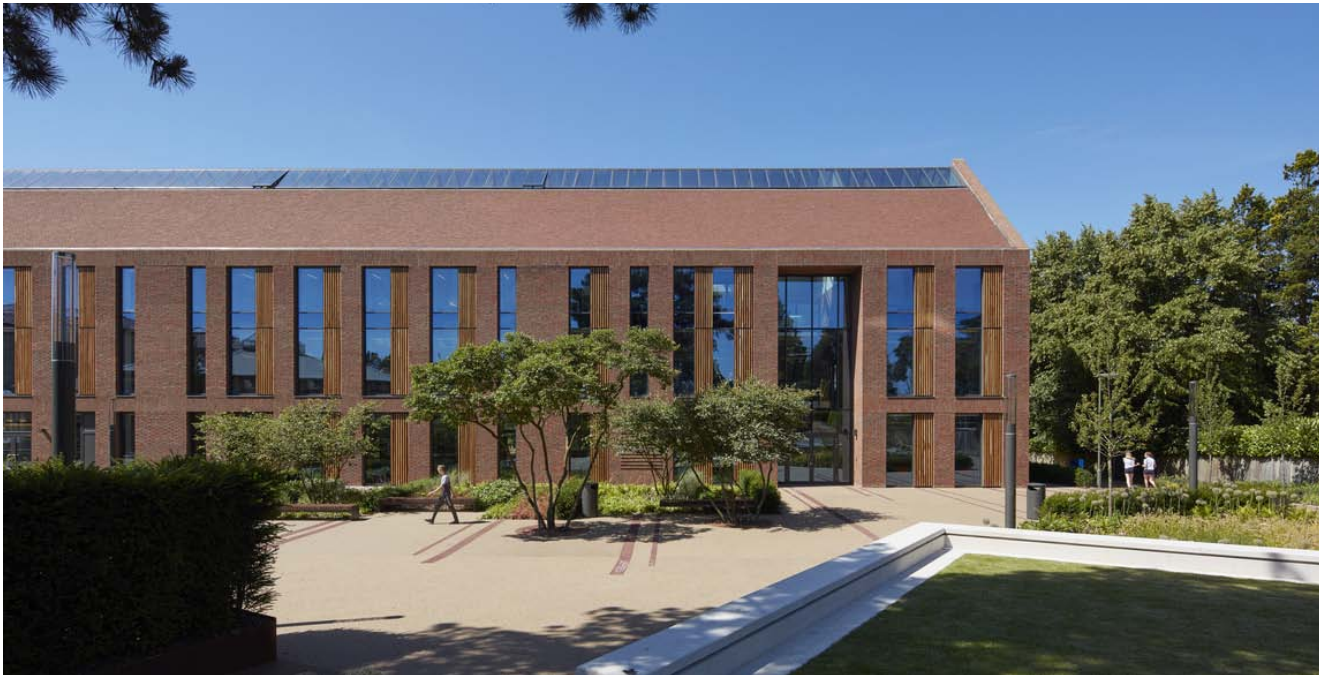
Het eventuele gebruik van baksteen in aardetinten als hoofdmateriaal voor de buitengevels schept samenhang. referentie: Reigate Grammar School - Walters & Cohen Architects
